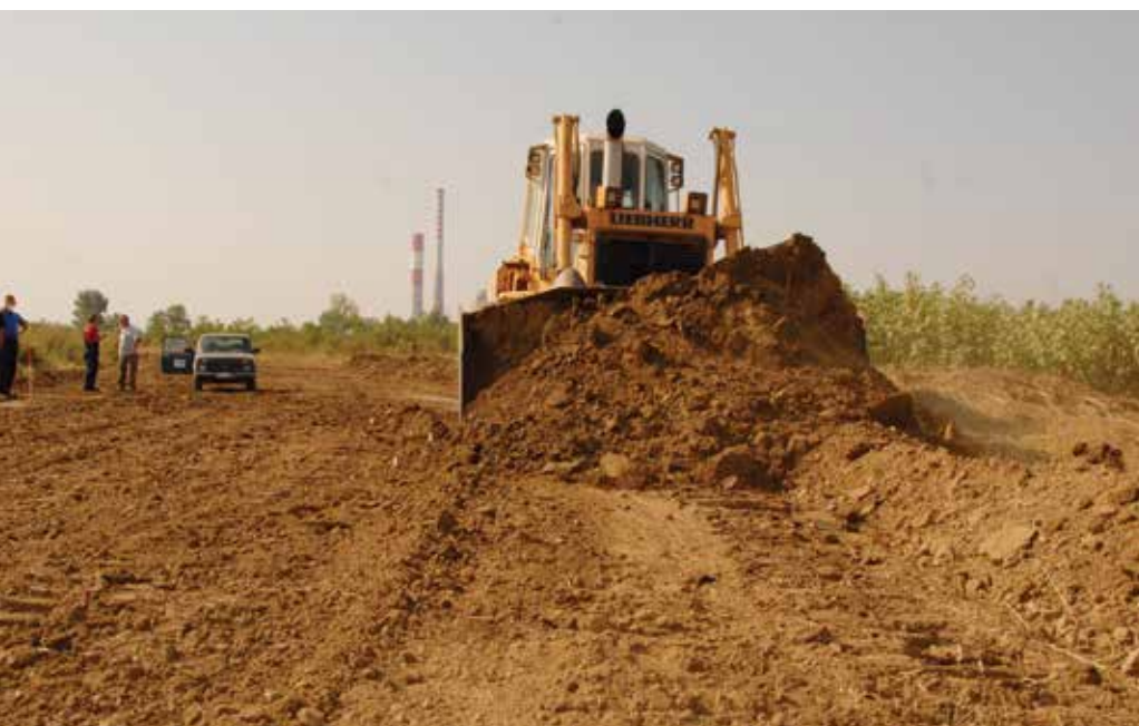
■ Изградња трасе западног гравитационог цевовода
